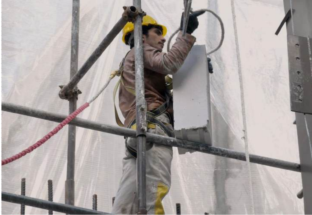
عایق کاری و اجرای هبکلس، دیوار حائل شرقی زون ۳، طبقه ۵- تاریخ عکس ها: ۱۳ دی ۱۴۰۱
