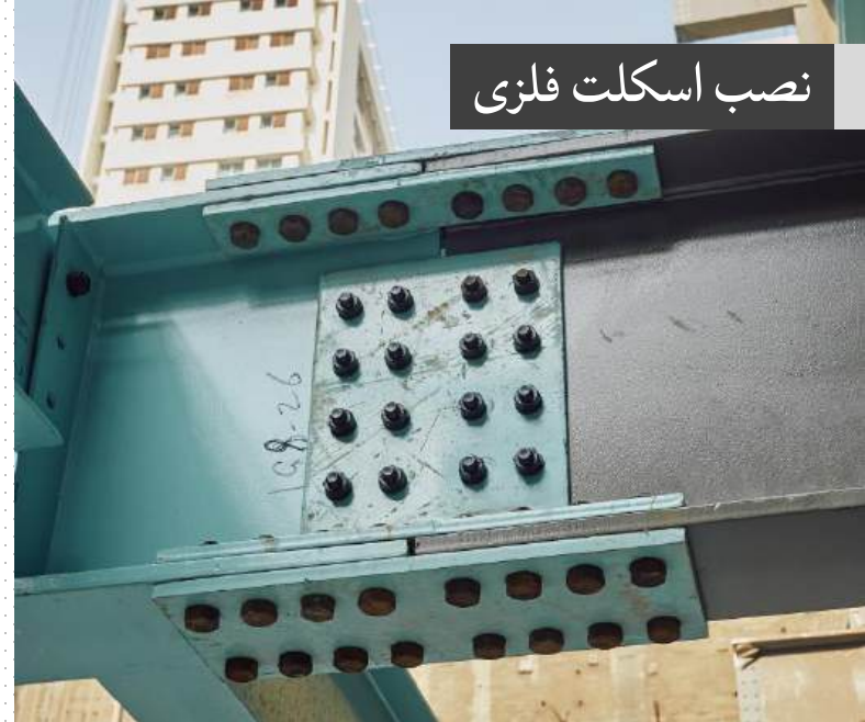
انتقال و نصب تیرهای طبقه ۴ - زون ۵ تاریخ عکس‌ها: ۱۳ دی ۱۴۰۱
